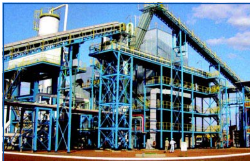
Vista parcial da Usina Vale do Paranaíba
