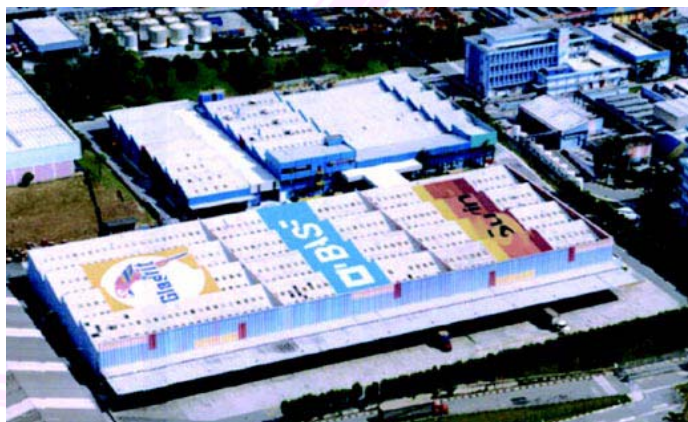
Unidade de produção de tintas da Basf em São Bernardo do Campo: planta Glassurit é sinônimo de sucesso. Pág. 2
