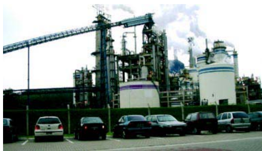
VCP: modernização com a unidade em operação
