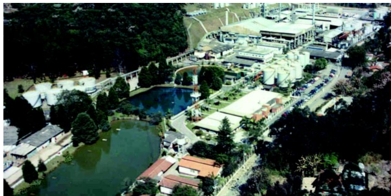
La planta de Petrom
