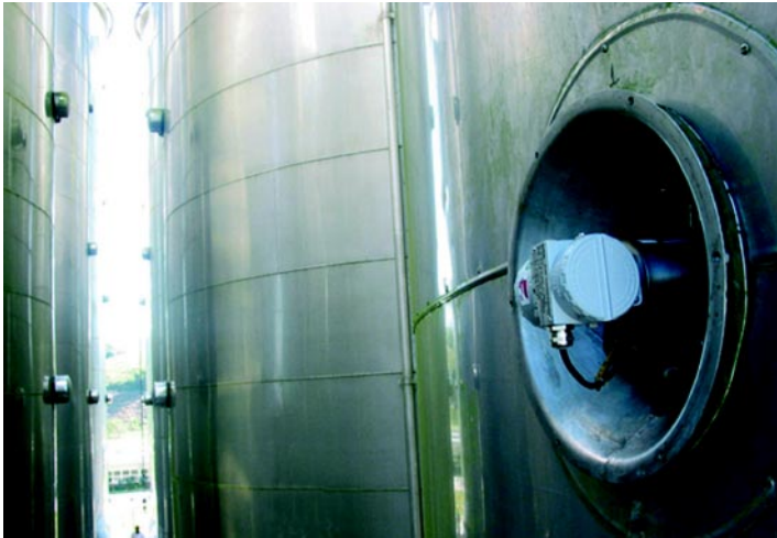
Optimización del consumo de energía y calidad de la cerveza: el DT302 indica el final del proceso de fermentación
