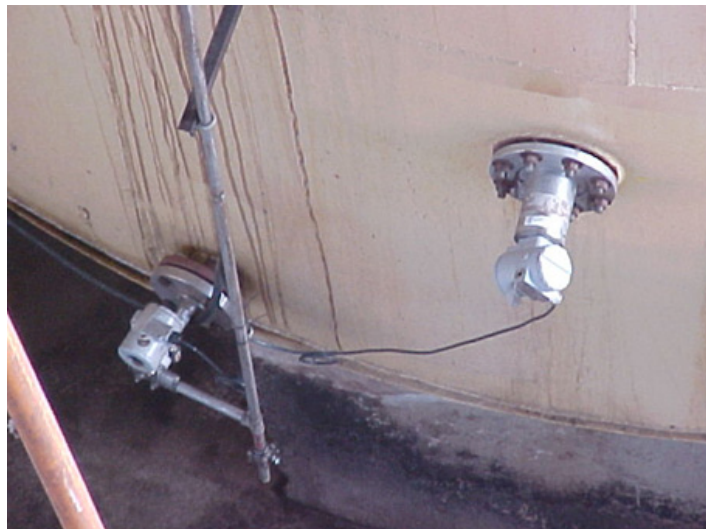
Instalação do DT301 e do LD301 na Dorna de Fermentação
