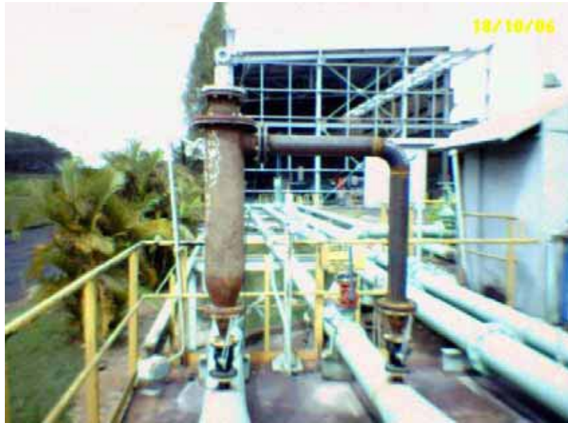
Figura 2.14 – Instalación en el lazo de prueba del ducto de mineral
