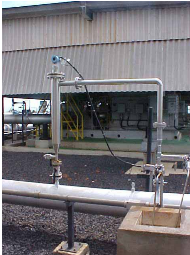
Figura 2.25 – Medición de densidad para identificación del producto
