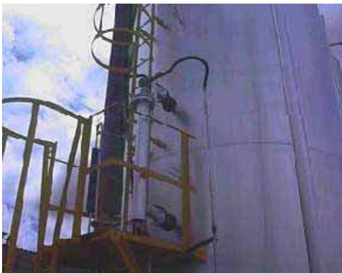
Figura 2.23 – Medición de Nivel de Interfase (Agua salada/Aceite)
