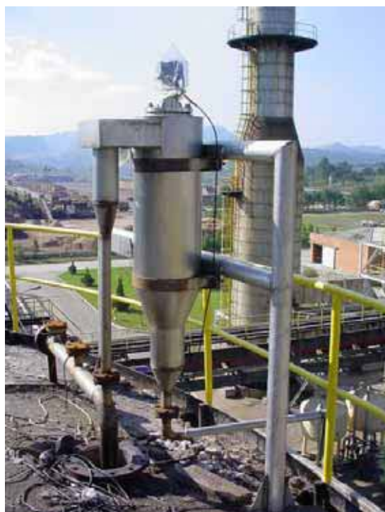
Figura 2.36 – Medición de Licor Negro (Flujo Ascendente)
