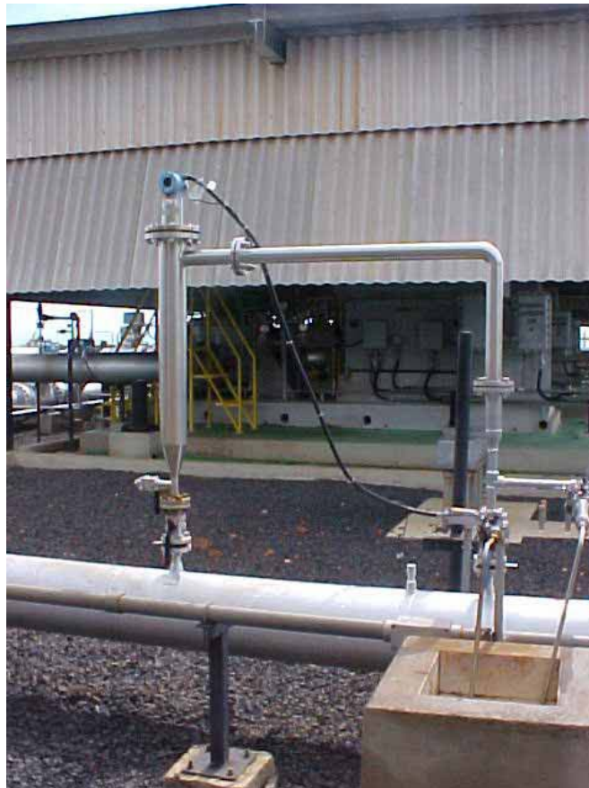
Figura 2.25 – Medición de densidad para identificación del producto
