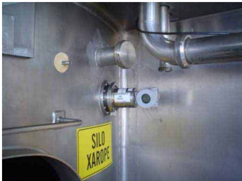
Figura 2.33 – DT Midiendo °Brix del Agua Dulce
