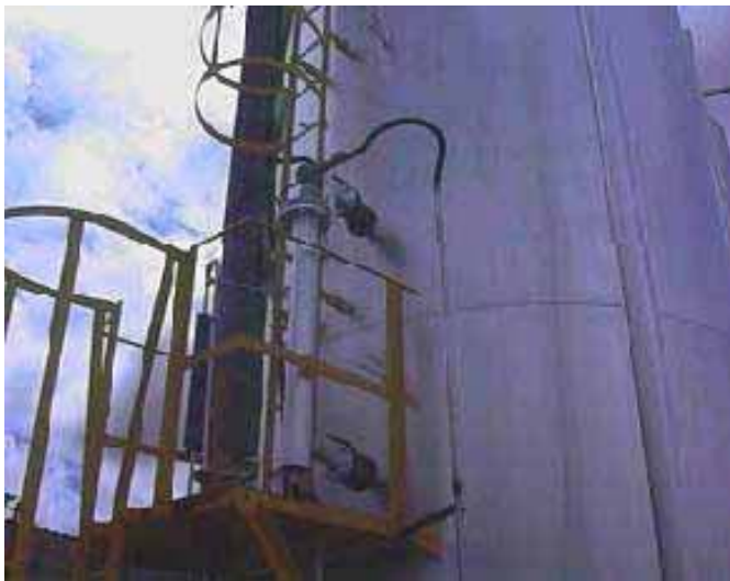
Figura 2.23 – Medición de Nivel de Interfase (Agua salada/Aceite)
