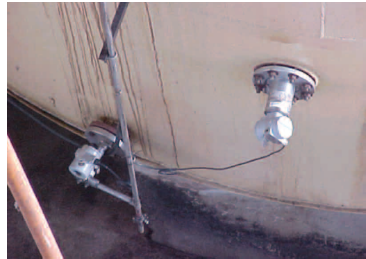
Ilustración fotográfica de instalaciones de transmisores de nivel LD301L y de densidad/concentración DT301
